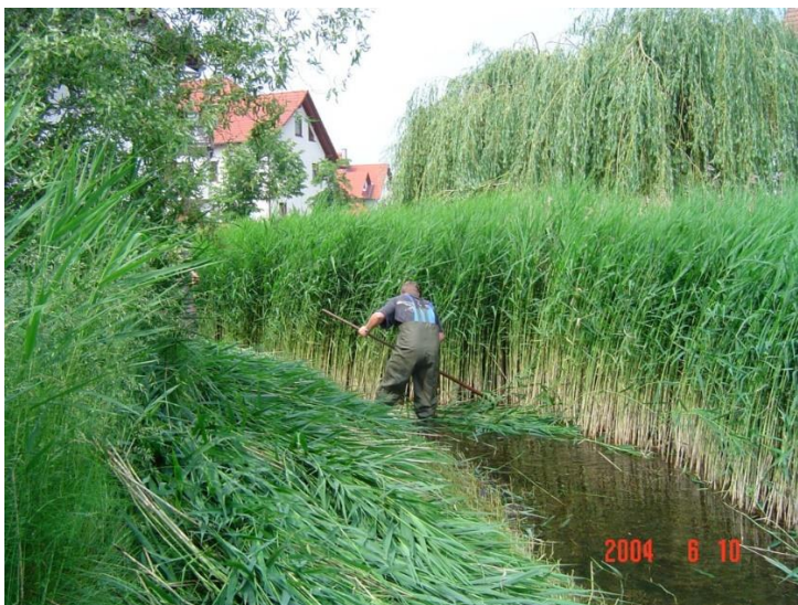
Abbildung 9: Handmahd Böschung und Sohle
