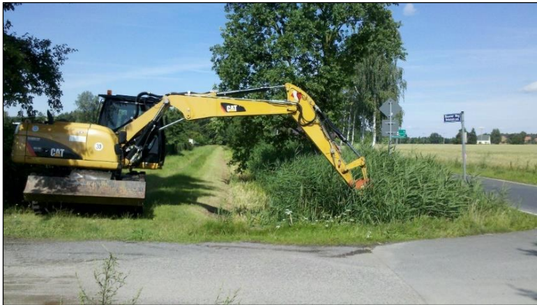
Abbildung 2: Mähkorbeinsatz mit Mobilbagger
