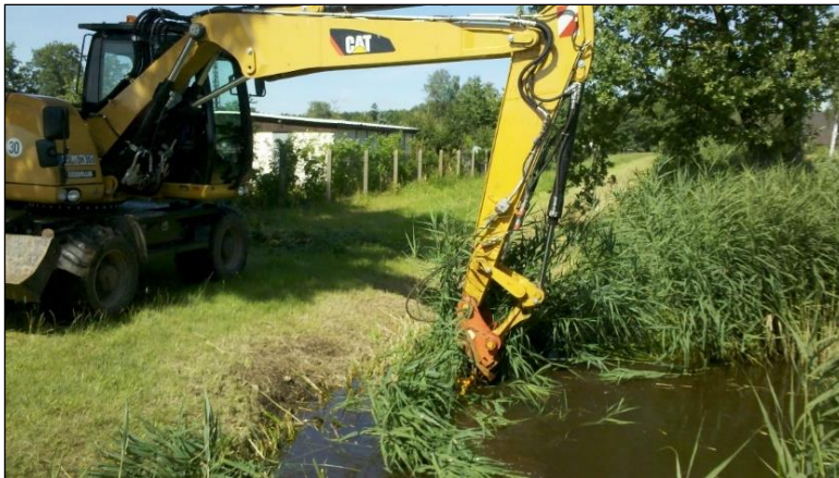
Abbildung 3: Sohlkrautung, Mähgut wird auf Unterhaltungstreifen (Fahrspur des Baggers) abgelegt
